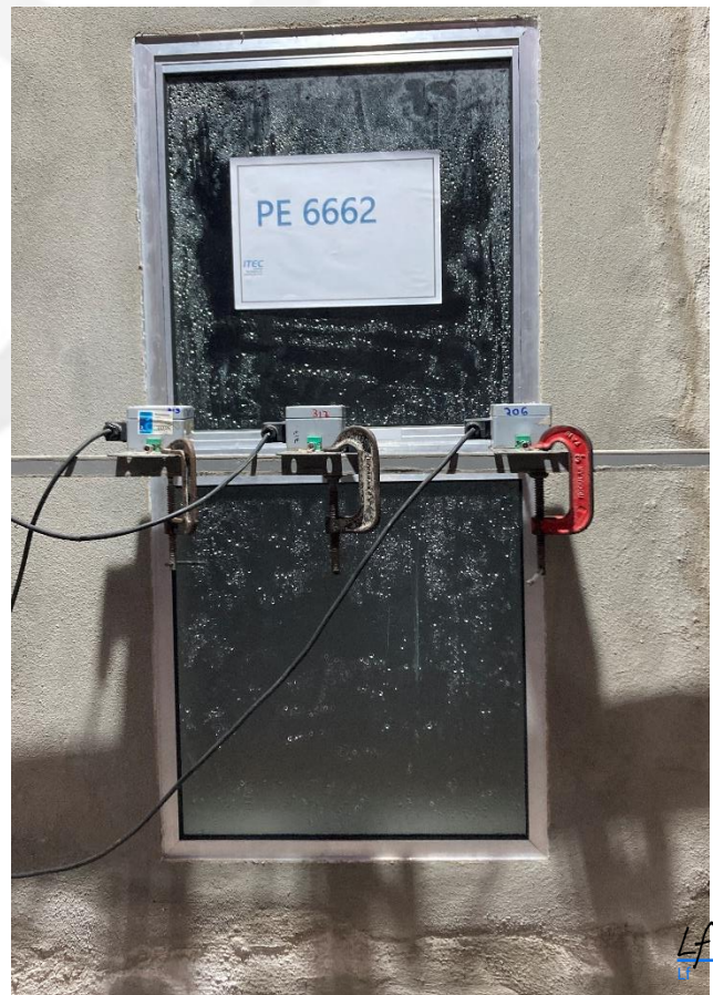
Foto nº. 02 Verificação do Comportamento quando submetida a cargas uniformemente distribuídas: Posicionamento dos deflectômetros.
