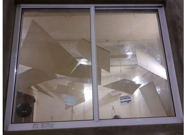
Foto 2 – Janela vista da câmara de recepção.
