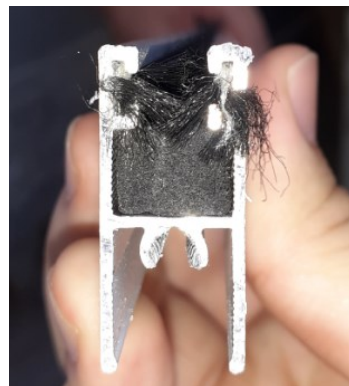
Foto 9 – Manta de compósito plástico que preenche as travessas superior e inferior da folha.
