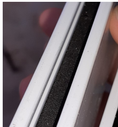
Foto 10 – Manta de compósito plástico que preenche os montantes laterais.
