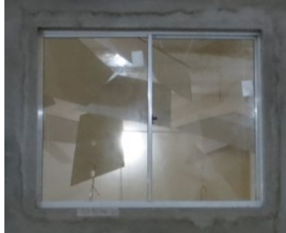
Foto 2 – Janela vista da câmara de recepção.
