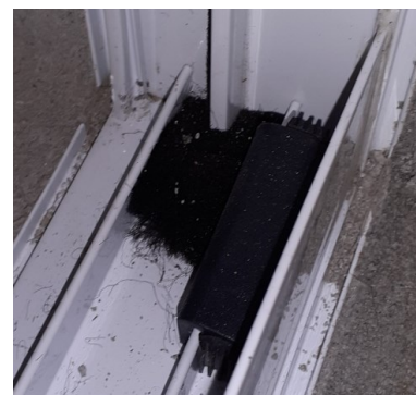
Foto 5 – Segmento de escova presente nas laterais das travessas do marco.
