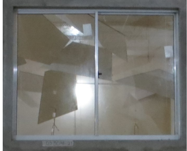
Foto 2 – Janela vista da câmara de recepção.
