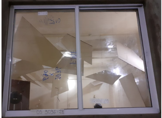
Foto 2 – Janela vista da câmara de recepção.
