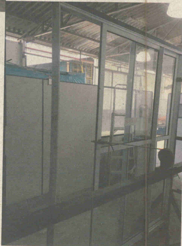
Foto nº. 08 Ensaio de resistência a flexão, do lado interno para o externo.
