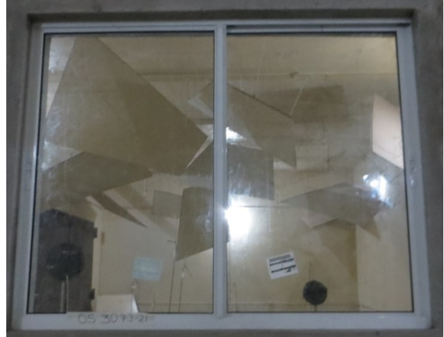
Foto 2 – Janela vista da câmara de recepção.
