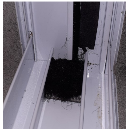
Foto 5 – Segmento de escova presente nas laterais das travessas do marco.
