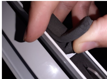
Foto 10 – Manta de composto plástico que preenche os montantes laterais da folha.
