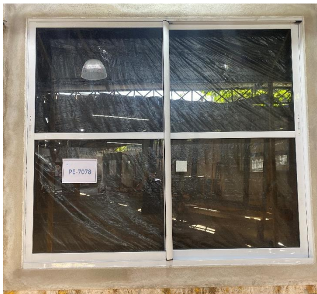
Foto nº. 01 Vista interna do protótipo ensaiado.
