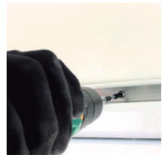
Reposicione o marco da janela e coloque os parafusos 4,8x38mm nas buchas 6mm de maneira alternada, verificando sempre o prumo, nível e esquadro.
